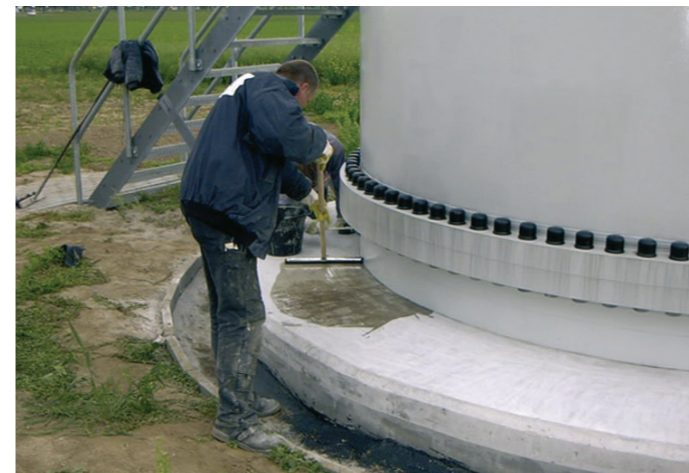
Grundierung des Untergrundes.
