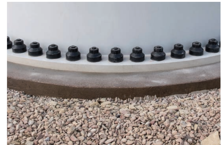
Abstreuen der KEMPERTEC® EP5-Grundierung. (nicht bei KEMPERTEC® AC-Grundierung)
