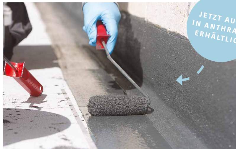
Die Flüssigabdichtung ist geeignet für Anschlüsse, Detailsbildungen und Flächen, bei Neubau und Sanierung.
