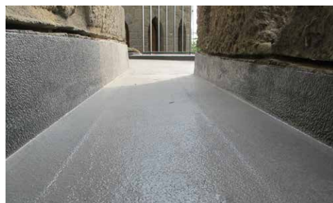
Schnell und sicher: Mithilfe von KEMPEROL konnten die Laufwege der Löwenburg rasch wieder in vollem Umfang genutzt werden.
