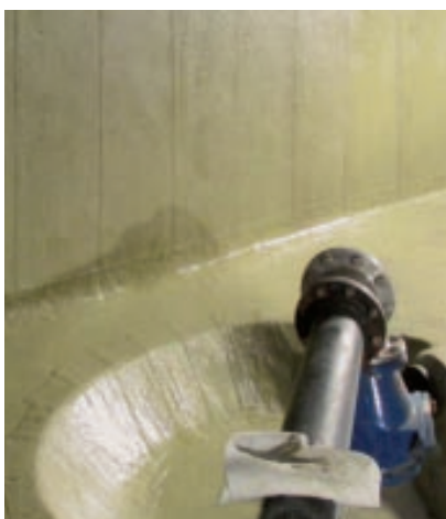
Innen wurde der Löschwasserbehälter und außen das Dach abgedichtet.
