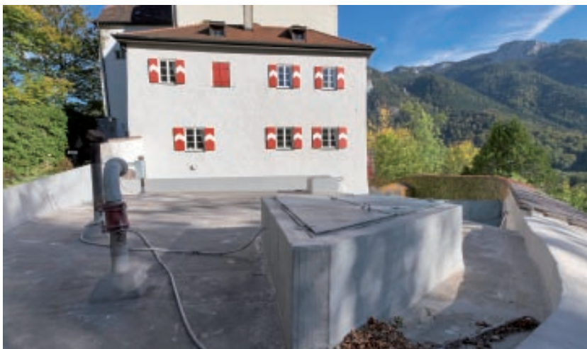
Die Wasserentnahmestelle auf dem Dach des Löschwasserbehälters.
