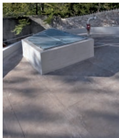
Innen wurde der Löschwasserbehälter und außen das Dach abgedichtet.
