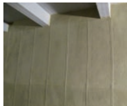
Eine Besonderheit bei der Abdichtung von Behältern ist die Verarbeitung von KEMPEROL® in der Senkrechten.
