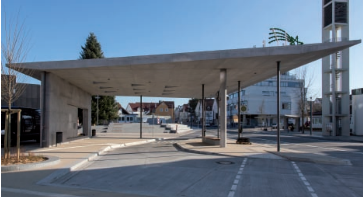
Werkstoff Beton: Die beiden neuen Bushaltestellen in der Ortsmitte von Rutesheim.
