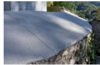
Die KEMPEROL® Abdichtung wurde über die Mauerkrone gezogen.
