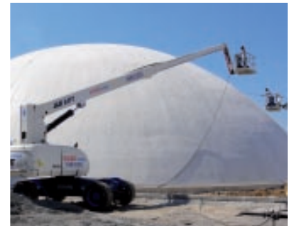
Die KEMPEROL®-Oberfläche wurde aus optischen Gründen mit einer farbstabilen weißen KEMPERDUR® Beschichtung versehen.
