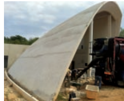
Ansicht der Betonkuppel während der Bauphase.
