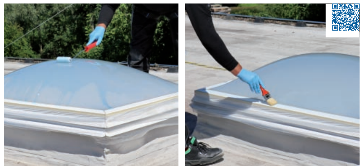
KEMPEROL® FALLSTOP wird mit einer Schaumstoffrolle im Kreuzgang aufgetragen. Das gesamte Material wird gleichmäßig und blasenfrei aufgebracht. Auch am Lichtkuppelrand wird das Material gleichmäßig verteilt.
