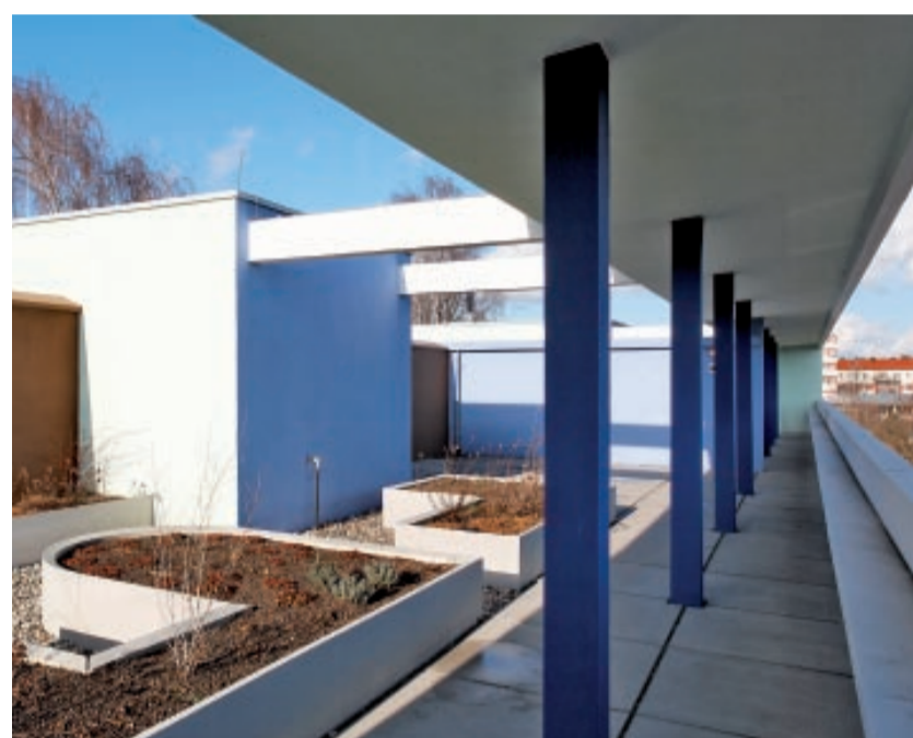
Dachgarten und Flugdach wurden mit KEMPEROL® abgedichtet.
