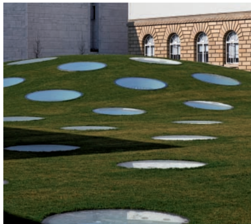
Unter der Erde befindet sich der Neubau des Städel Museums, Frankfurt/Main. Bei der Abdichtung der Dachfläche und der 195 Oberlichter vertrauten die Architekten auf KEMPEROL®.
