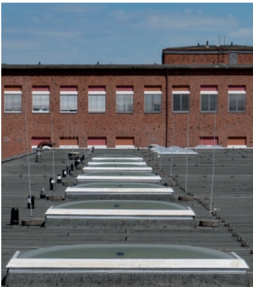
Die teilweise bis zu 30 Jahre alten Lichtelemente wurden vor Ort mit KEMPEROL® FALLSTOP beschichtet.
