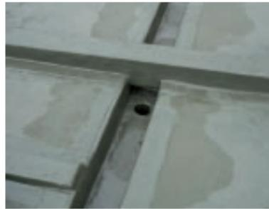
Wasser marsch: Die Dachentwässerung erfolgt über Rinnen, die in die Flächenabdichtung eingebunden sind.
