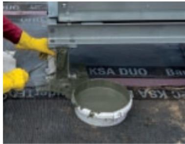
Fummelei: Die Abdichtung der kleinformatigen Klimaanlagenfüße lässt sich sicher nur mit einer Flüssigabdichtung durchführen.
