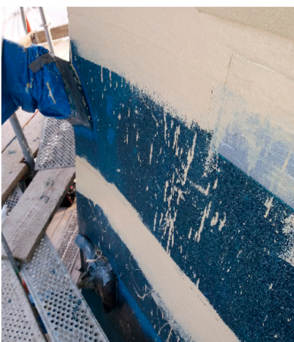
Die blau eingefärbte Grundierung macht eventuelle Fehlstellen sofort sichtbar.
