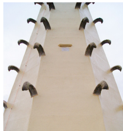
Das Armiervlies wurde Stoß auf Stoß verlegt, um eine möglichst plane Oberfläche zu erreichen.
