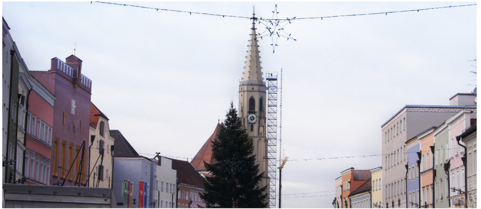
Eine Kemperol Abdichtung schützt den Turmhelm der Stadtpfarrkirche St. Nikolaus.
