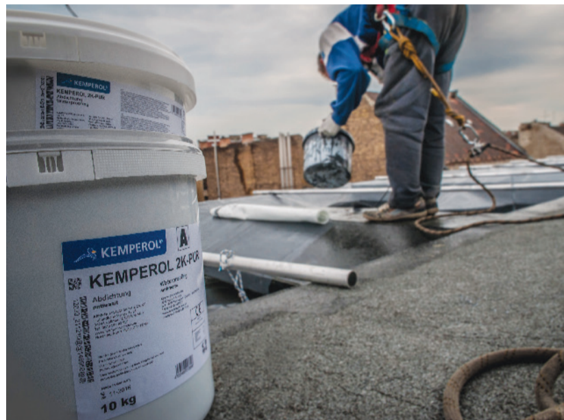
Das Dach der Gedenkstätte mit dem markanten Schriftzug „Haus des Terrors“ wurde mit KEMPEROL® abgedichtet. Für die kleinteilige Geometrie der Dachfläche war die Flüssigabdichtung ideal. In 20 Metern Höhe arbeiteten die Abdichter durchgängig mit alpiner Seiltechnik.
