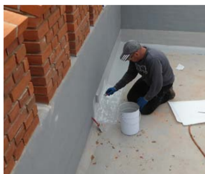
Die KEMPEROL® Abdichtung schützt die Plattform im Bereich des Zinnenkranzes und bewahrt die Bausubstanz vor weiterer Zerstörung. Die Flüssigabdichtung bildet eine homogene, nahtlose Schutzschicht. Neu eingebaute Abläufe sorgen für eine sichere Entwässerung.
