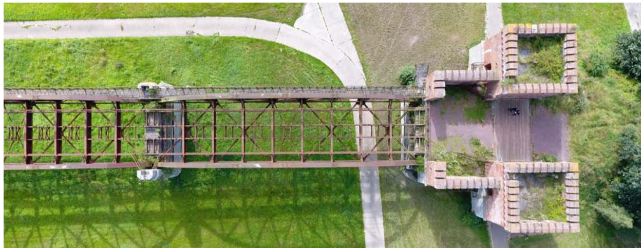
Blick von oben auf den unsanierten Brückenkopf. Unter dem Turm mit Zinnenkranz befinden sich kasemattenartige Gewölbe.
