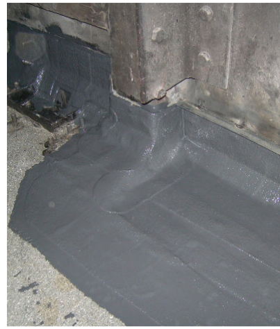
Die Metallfüße der Stimmgabeln wurden mit KEMPEROL® abgedichtet. Auch die Anschlüsse im Bereich von acht ehemaligen Ladeluken wurden mit KEMPEROL® ausgeführt. Fotos: Jeff Schindler
