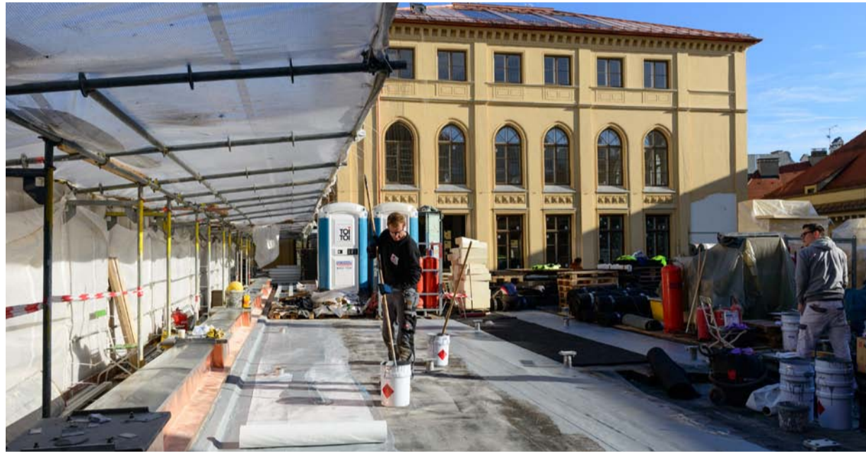
Ein Schadensfall würde zu enormen Folgekosten führen, deshalb kam den Abdichtungsarbeiten von Anfang ein besonderes Gewicht zu.
