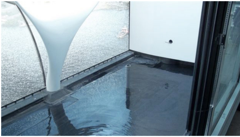
Die Metallfüße der Stimmgabeln wurden mit KEMPEROL® abgedichtet. Auch die Anschlüsse im Bereich von acht ehemaligen Ladeluken wurden mit KEMPEROL® ausgeführt. Fotos: Jeff Schindler
