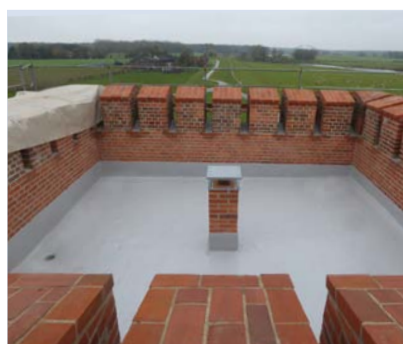
Die KEMPEROL® Abdichtung schützt die Plattform im Bereich des Zinnenkranzes und bewahrt die Bausubstanz vor weiterer Zerstörung. Die Flüssigabdichtung bildet eine homogene, nahtlose Schutzschicht. Neu eingebaute Abläufe sorgen für eine sichere Entwässerung.
