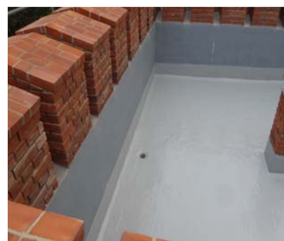
Die KEMPEROL® Abdichtung schützt die Plattform im Bereich des Zinnenkranzes und bewahrt die Bausubstanz vor weiterer Zerstörung. Die Flüssigabdichtung bildet eine homogene, nahtlose Schutzschicht. Neu eingebaute Abläufe sorgen für eine sichere Entwässerung.
