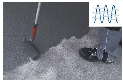
Die somit versiegelte Fläche muss ca. **12 Stunden** aushärten. Nach **24 Stunden** ist die Beschichtung voll belastbar und die Ladefläche wieder einsatzbereit.
